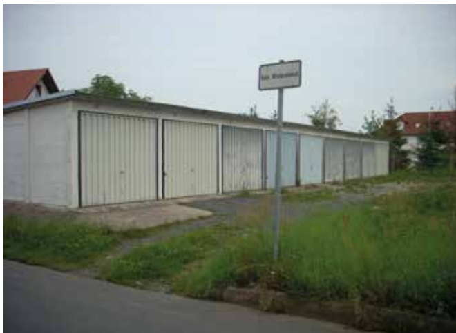
Garagenstandort Mittelgasse in Naundorf Foto: Stadtverwaltung Großenhain
